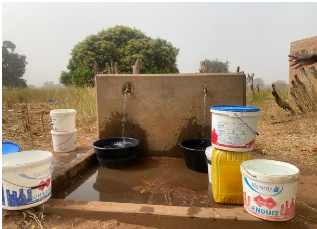
Photo 1 : Forage équipé de robinets servant à l'approvisionnement en eau potable dans le village de Balam Boulou (cliché COUNDONO, décembre 2024)
