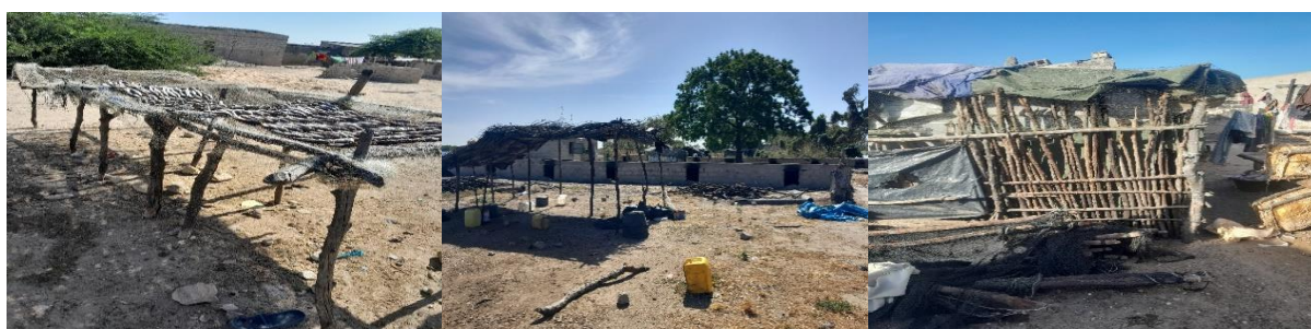
Figure 9 : Usages du bois de mangrove dans la construction
