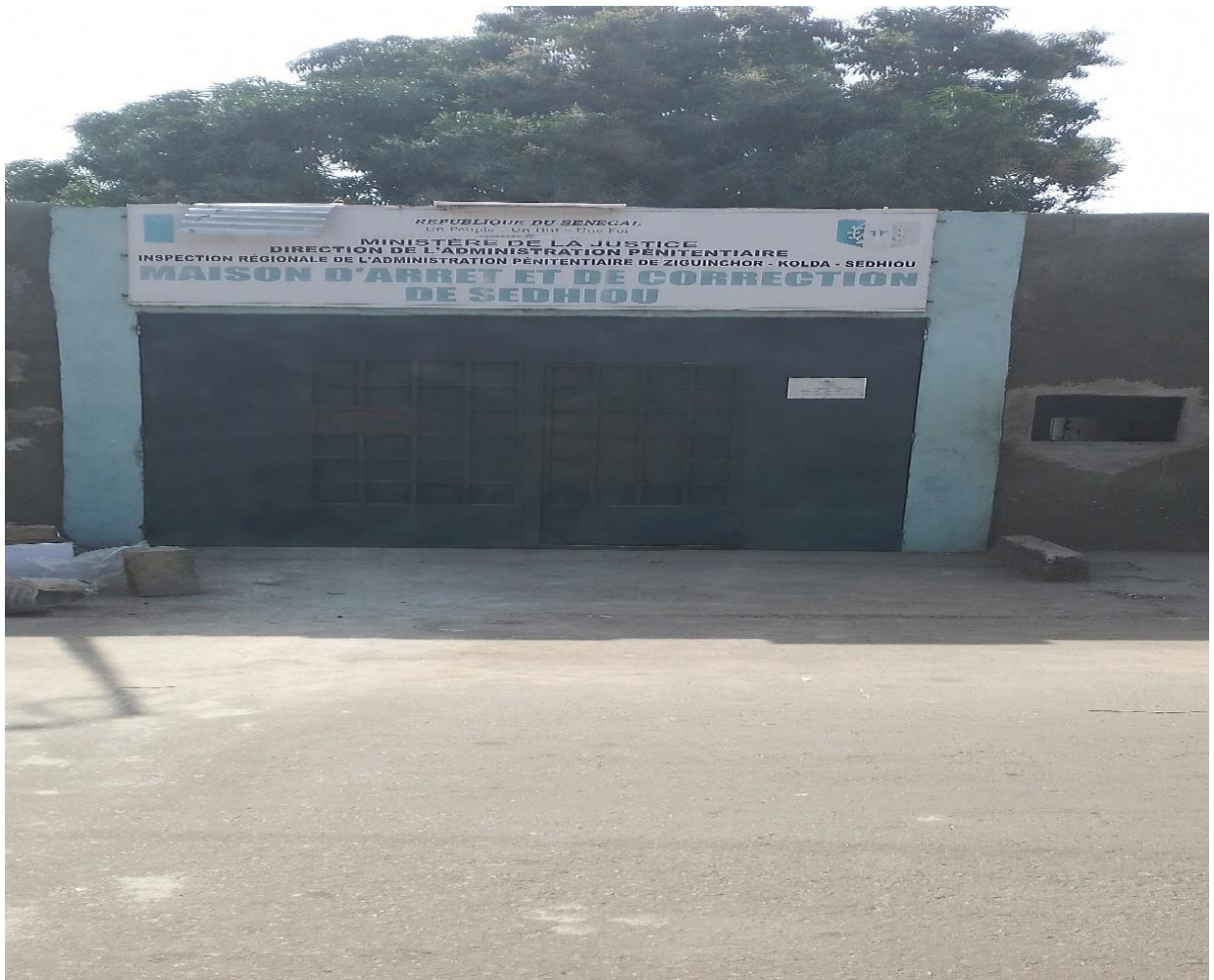
Figure 13: L'Accès principal de la MAC de Sédhiou (Photo prise le 08/01/2025 à 11h28)
